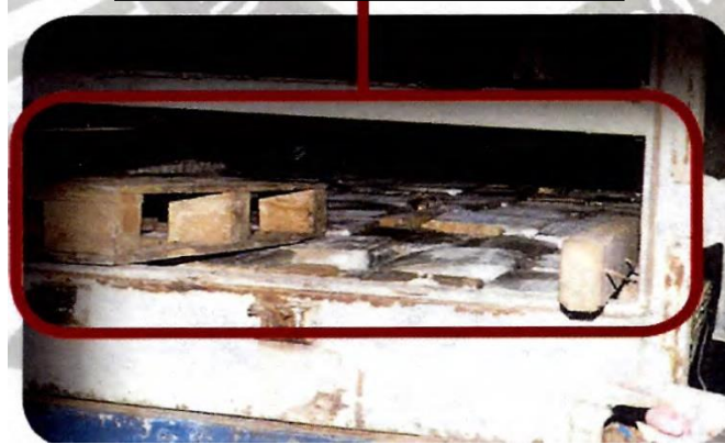
Espacio entre el piso y la base
