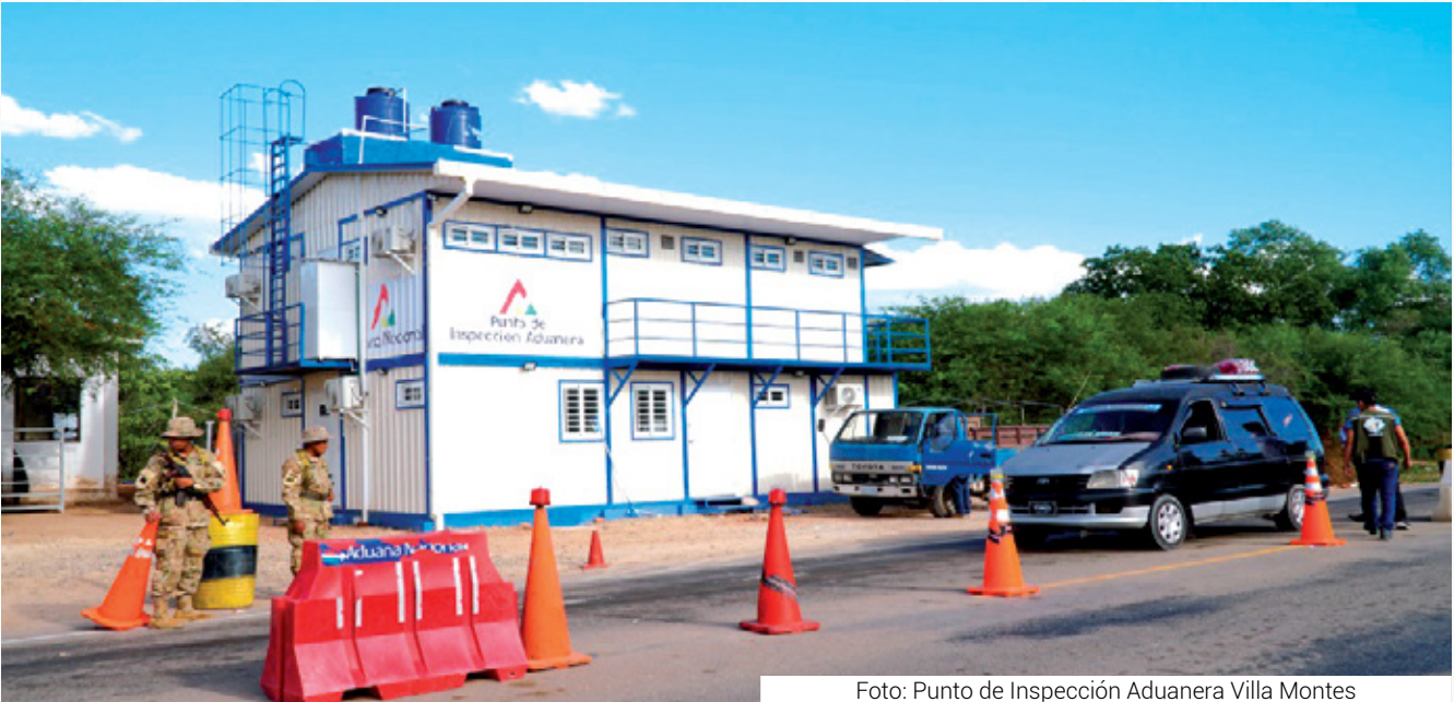
Foto: Punto de Inspección Aduanera Villa Montes
