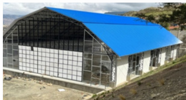
Adquisición de Infraestructura Prefabricada para Resguardo de Activos Fijos (Guaqui)
