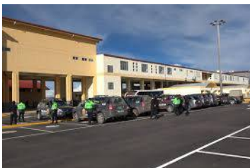
Instalaciones del CEBAF Desaguadero
