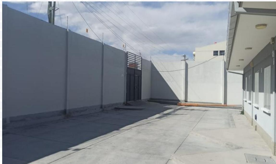
Se aumentó la altura del muro perimetral y se realizó la instalación del cerco eléctrico
