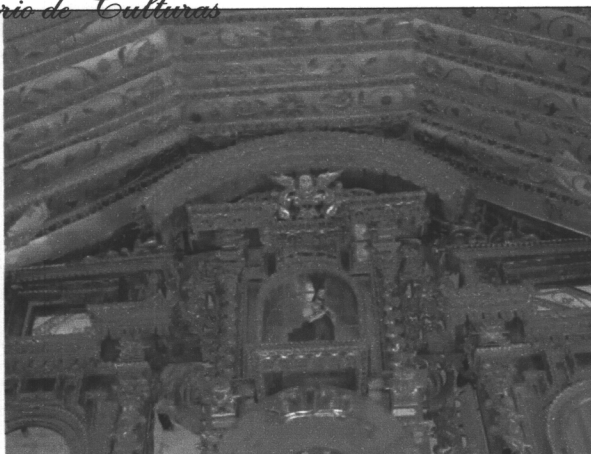
DESPUES DEL ROBO Faltan los lambrequines
