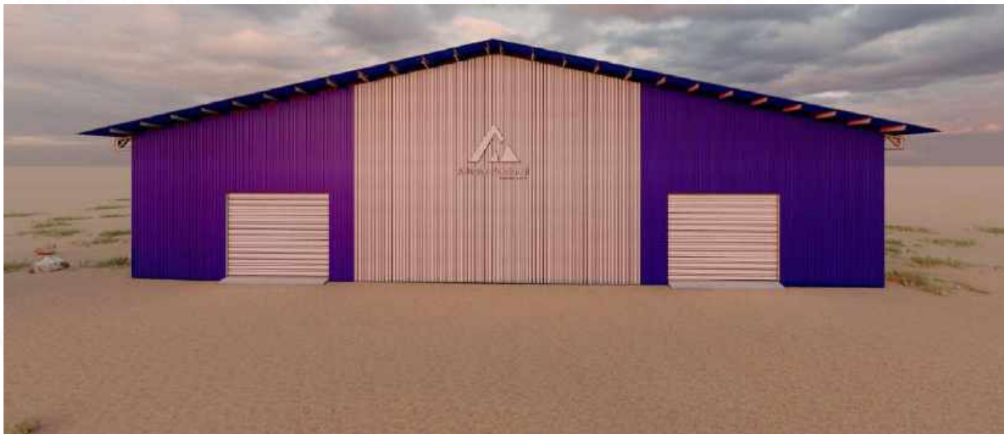
Infraestructura para Resguardo de Activos Fijos - Recinto Guaqui Monto: Bs. 2.990.000
