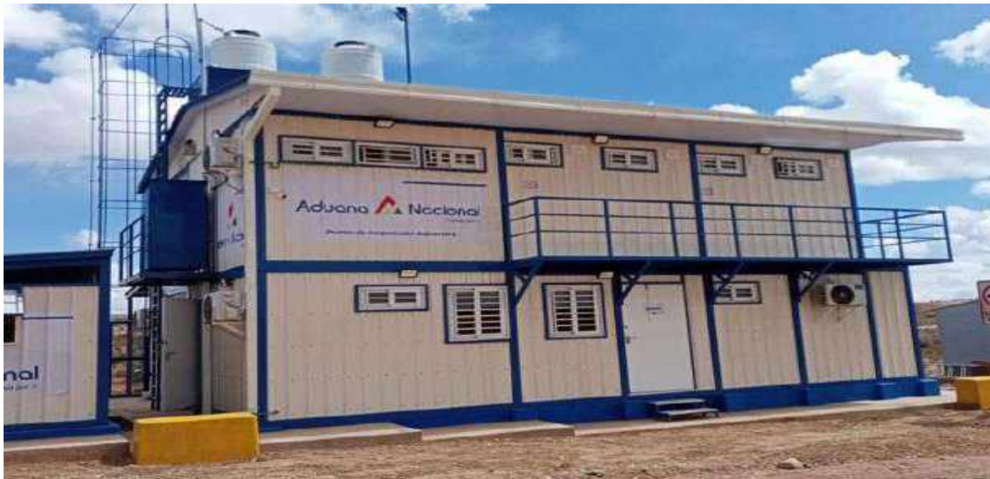
Cierres Perimetrales Puntos de Inspección Aduanero Yata, Achica Arriba, Botijlaca Monto: Bs. 450.000
