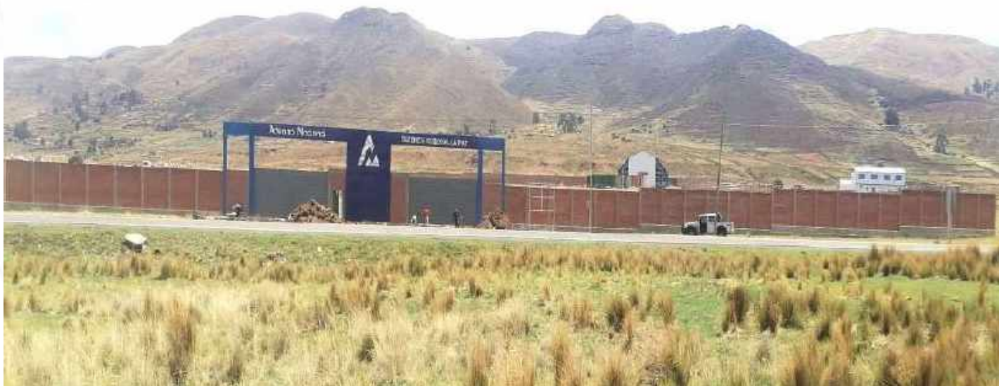
Iluminación Exterior Recinto Guaqui – Aduana Frontera Desaguadero Monto: Bs. 300.000
