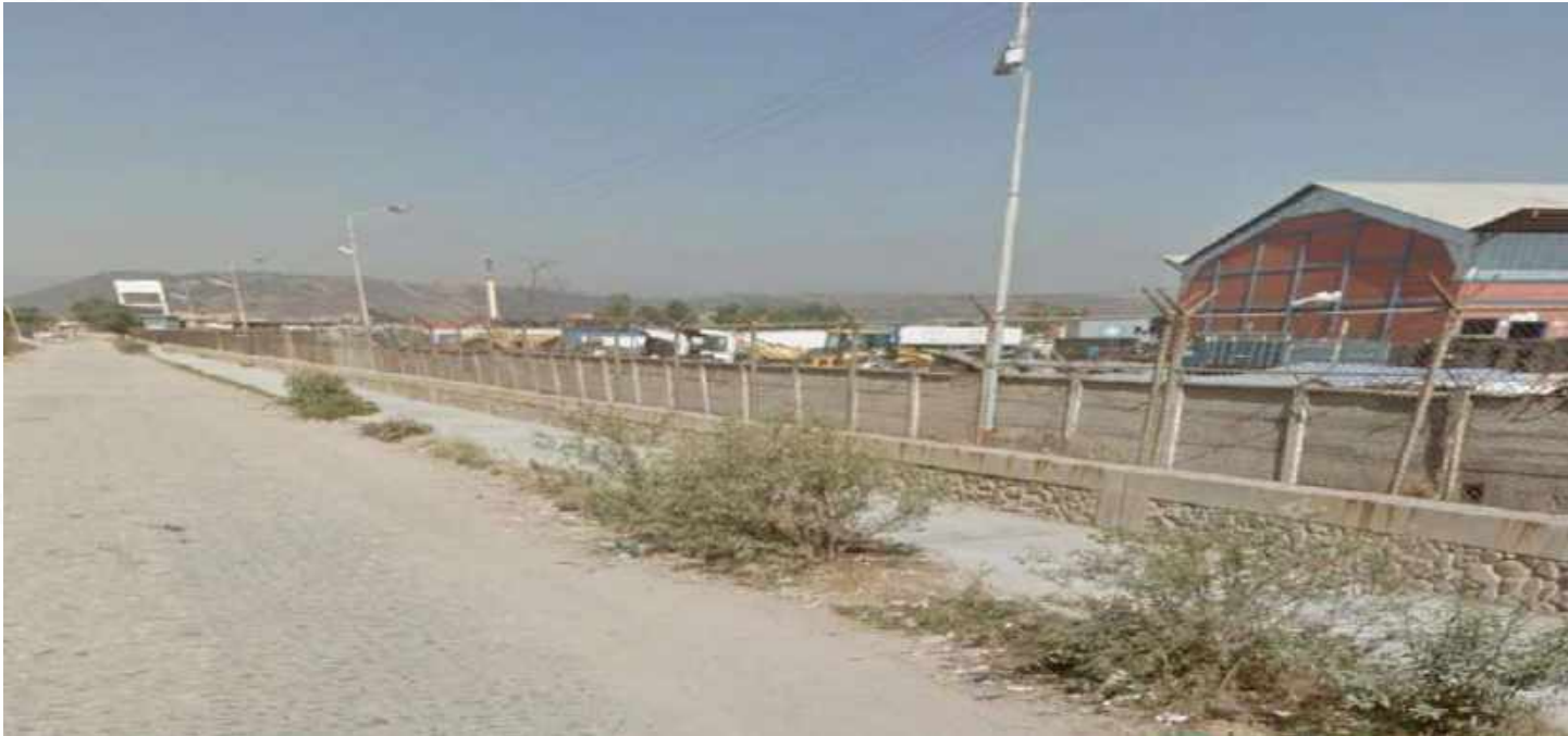
Cerramiento Perimetral Gerencia Regional Cochabamba - Fase II Monto: Bs.800.000
