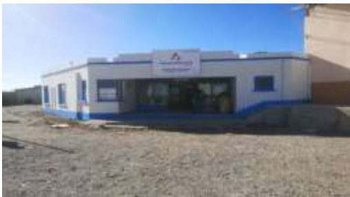
Mantenimiento Infraestructura Administración Aduana Charaña Monto: Bs. 149.549
