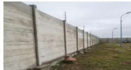
Mejoramiento Cierre Perimetral Administración Aduana Frontera Bermejo (Porcelana) Monto: Bs. 438.598
