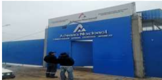
Mantenimiento, Mejoramiento y Re adecuación Infraestructura Administración Aduana Frontera Bermejo (Porcelana) Monto: Bs. 576.845
