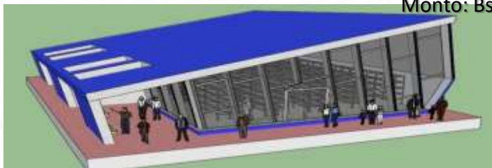
Adquisición Archivo Prefabricado Aduana Interior Santa Cruz (Pampa de la Isla) Monto: Bs.1.100.000
