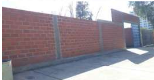
Mejoramiento y Mantenimiento Terreno (Av. German Bush) Aduana Nacional – Tarija Monto: Bs. 171.738
