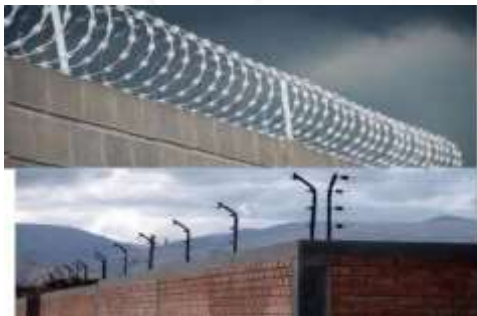
Electrificación de los cerramientos en Recintos Aduaneros Monto: Bs. 200.000
