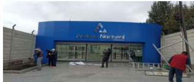
Mantenimiento, mejoramiento y Readecuación Infraestructura Aduana Interior La Paz Monto: Bs. 1.490.264
