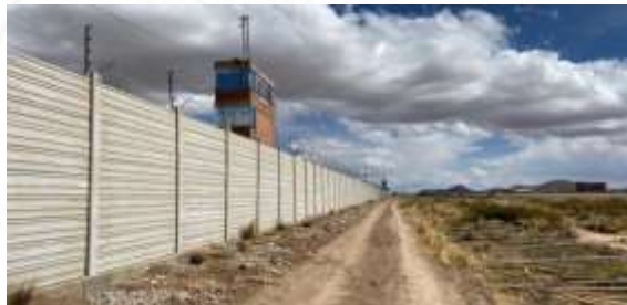
Mejoramiento Cierre Perimetral Administración Aduana Interior Pasto Grande Monto: Bs. 975.188
