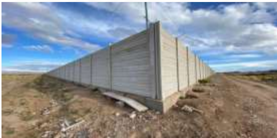
Cerramiento de los PIAS (Punto de Inspección Aduanera) Monto: Bs. 2.000.000
