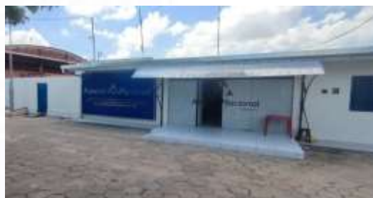
Mantenimiento Infraestructura Aduana Interior Santa Cruz (SPCC - Av. Brasil) Monto: Bs. 441.713
