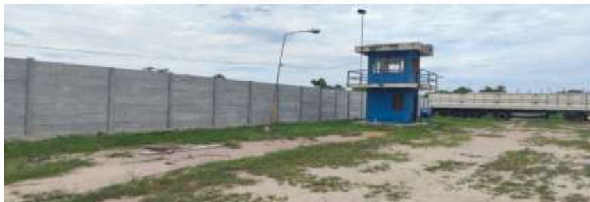
Mantenimiento y Mejoramiento Cerramiento Perimetral Administración Frontera Yacuiba (Campo Pajoso) Monto: Bs. 996.667
