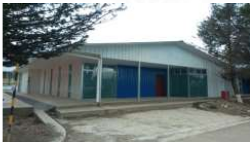
Mantenimiento y Ampliación Oficinas Gerencia Regional La Paz - Fase II Monto: Bs. 576.845
