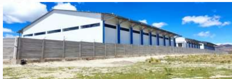
Mejoramiento Cierre Perimetral Administración Aduana Interior Potosí (Azangaro) Monto: Bs. 506.351
