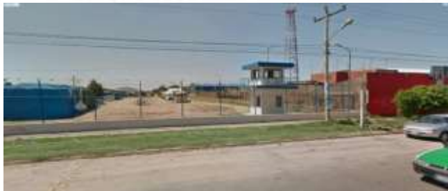
Mejoramiento Cierre Perimetral Aduana Interior Santa Cruz (Pampa La Isla) (Muro de concreto) Monto: Bs. 2.000.000,
